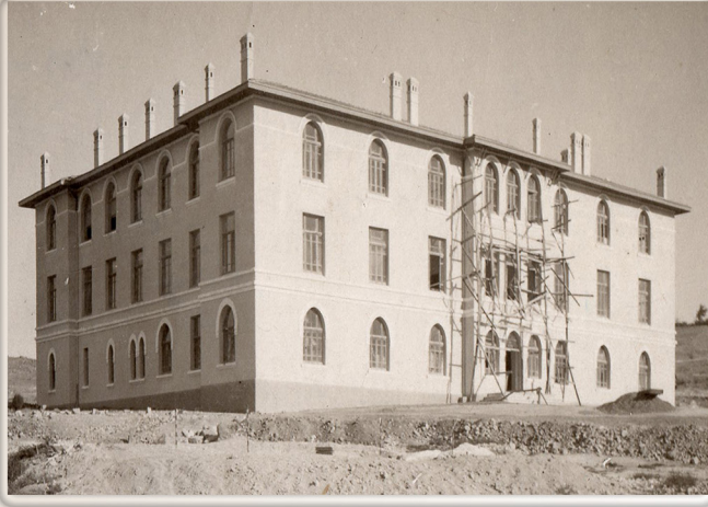
1926-1927 Yıllar / İnşaat Aşaması 1926-1927 / Construction Stage
