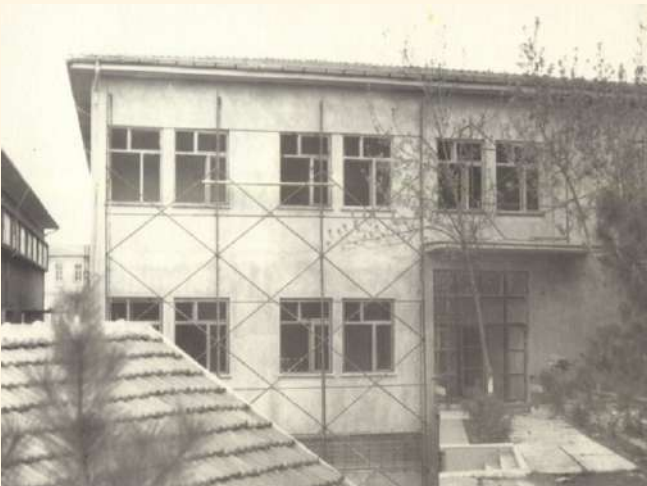
Harita Yüksek Teknik Okul Komutanlığı binası inşaatı, 1966. (Harita Genel Müdürlüğü arşivi)
