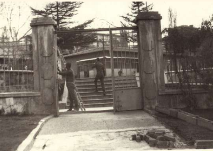
Karargâh binası arka bahçe girişi. (Harta Genel Müdürlüğü arşivi)
